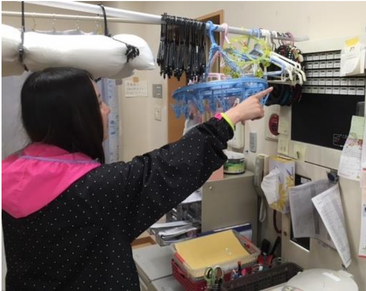
火災発報地区表示盤で出火元を確認！！
